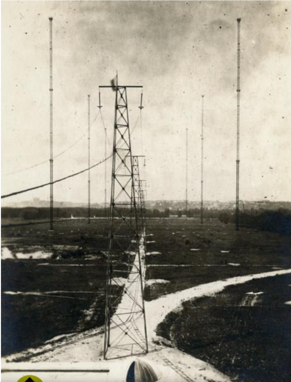
Vue des 6 pylônes de 8 de 180 m abattus en août 1944
