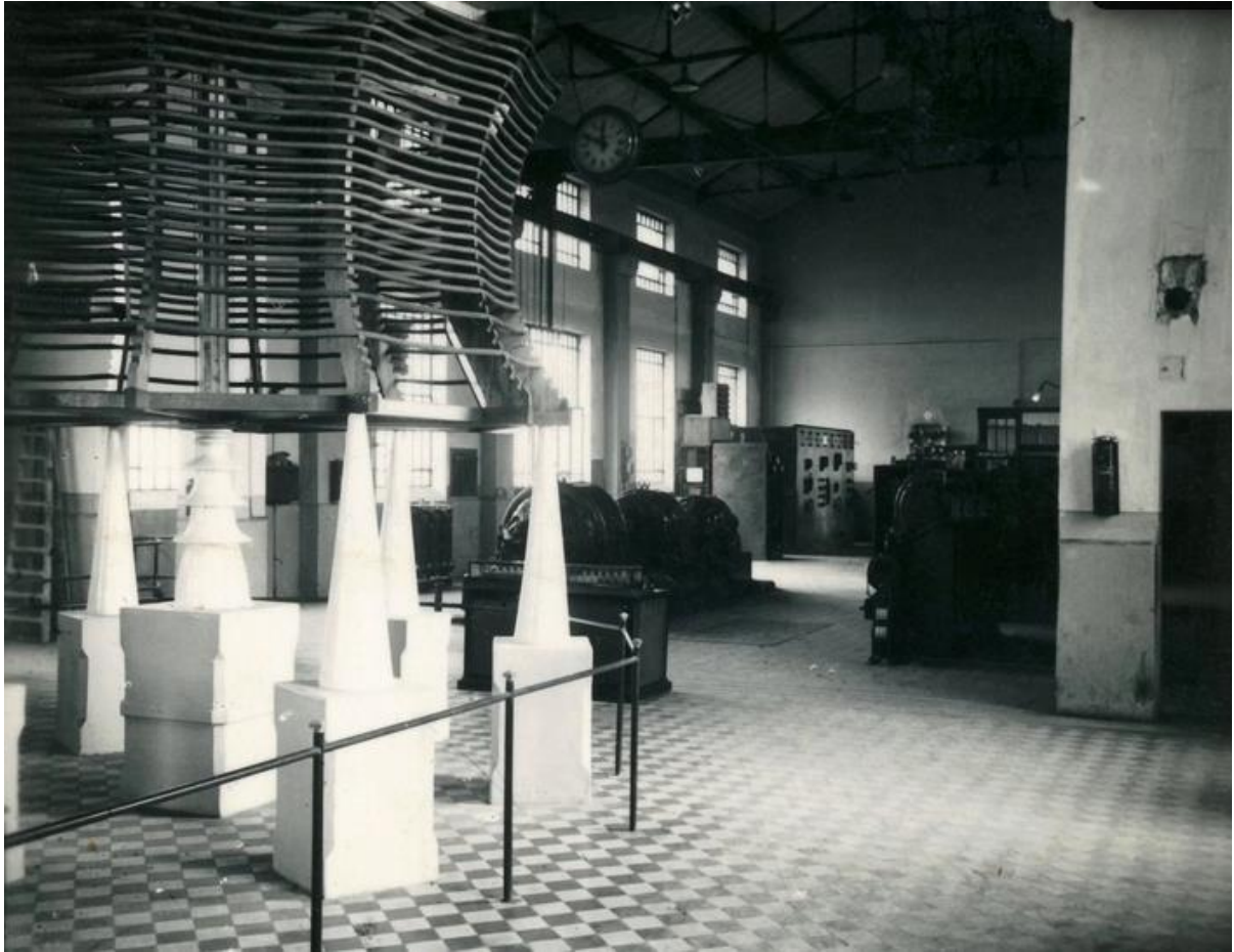
Intérieur façade nord : ensemble du poste FYN. Self d'antenne, clefs de manipulation, alternateur 250kw et alsacienne 500V. Au fond : tableau d'arrivées,1920 (photo Rougmond)
