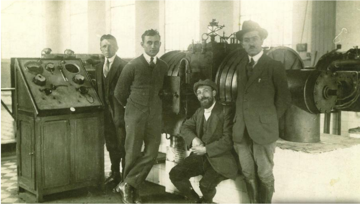
Le personnel de la station devant les machines, environ 1918
