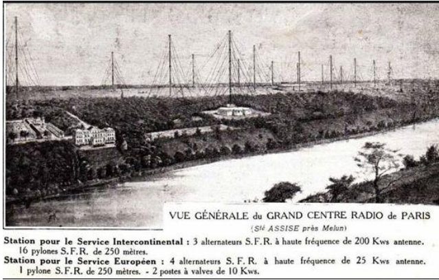
Vue générale de la station de Sainte-Assise - Publicité vers 1930
